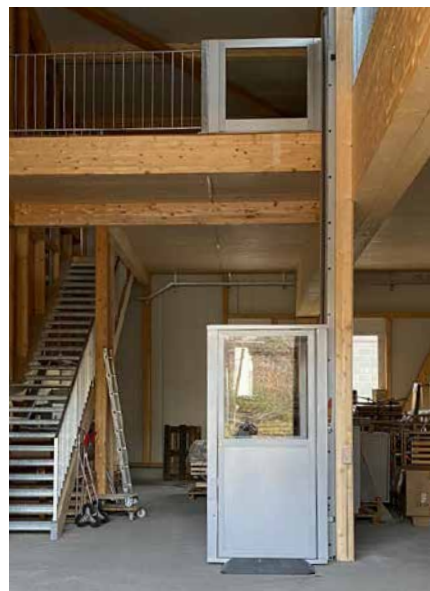
Lift avec cabine et portillon sécurisé au niveau supérieur
