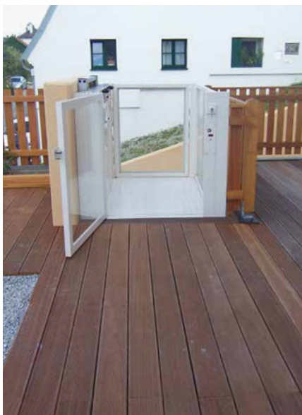
Accès supérieur avec porte à verrouillage électrique
