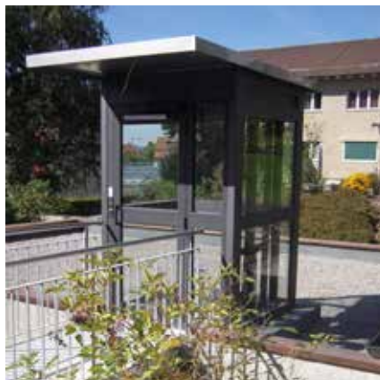
Sortie d'ascenseur sur le toit d'un garage
