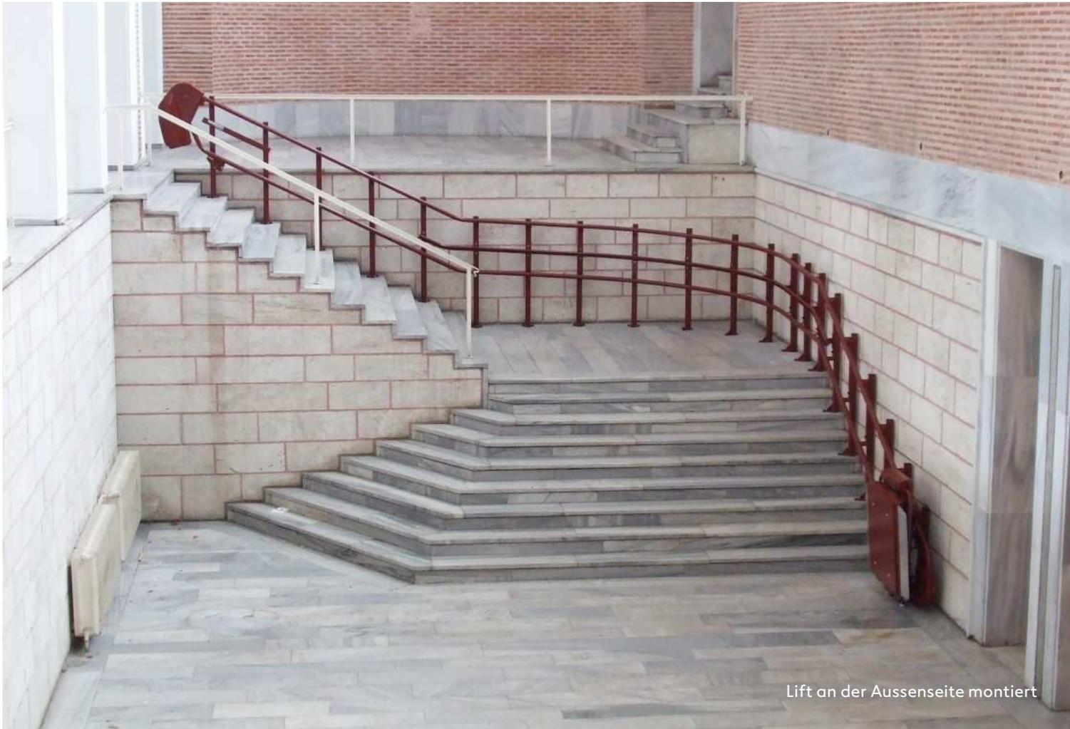
Lift an der Aussenseite montiert
