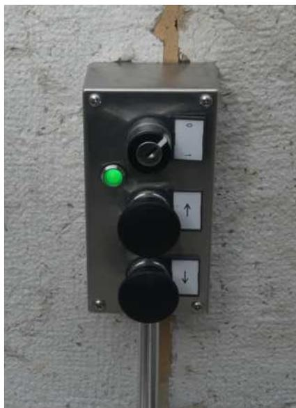
Commande d'arrêt d'appel supérieur intégrée dans la colonne
