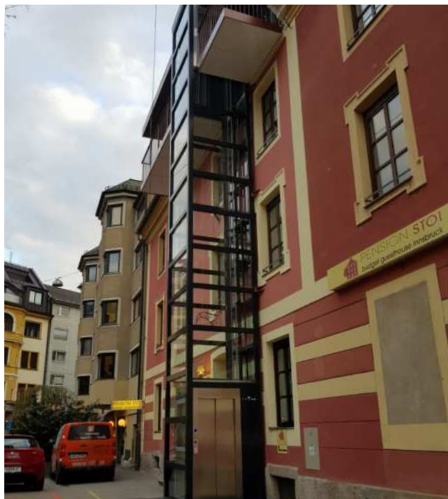
Installation im Aussenbereich
