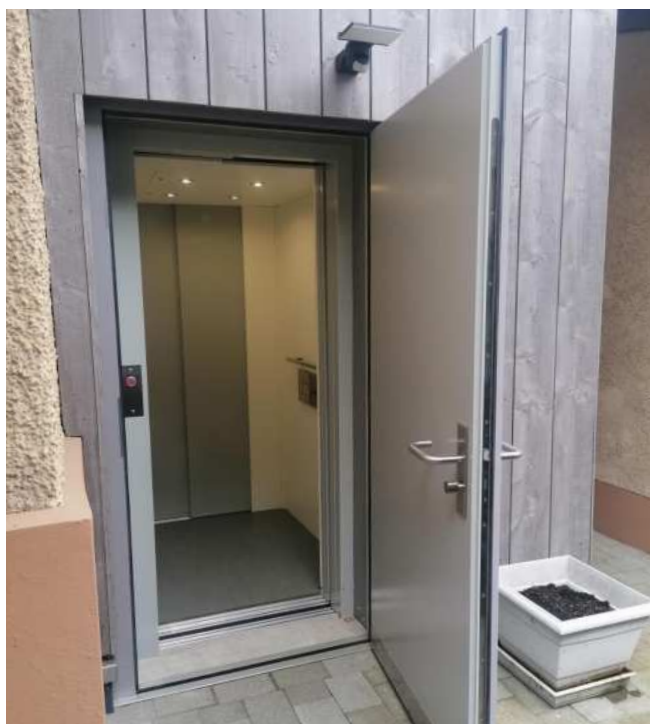
Lift mit Schiebetüre geöffnet hinter einer isolierten Zugangstüre
