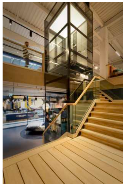
Ascenseur dans un bâtiment public
