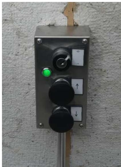
Bedienung Haltestelle oben in Säule integriert
