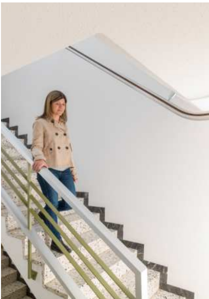
Schiene an der Decke Treppen sind frei
