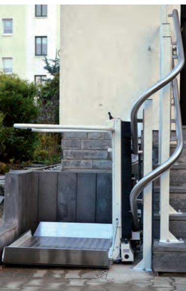
Installations extérieure et intérieure sur des piliers autoporteurs
