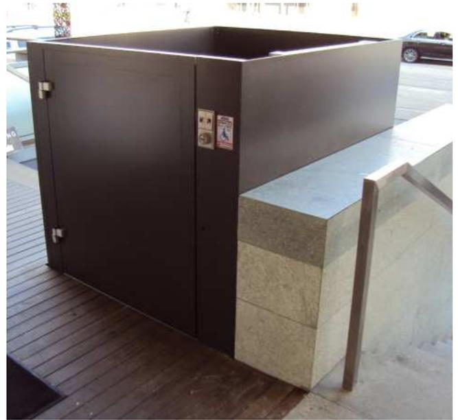
Oberer Schachtaufbau in Metall
