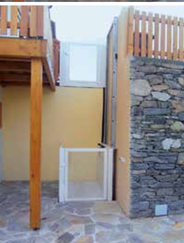
Oberer Zugang mit gesichertem Türelement
