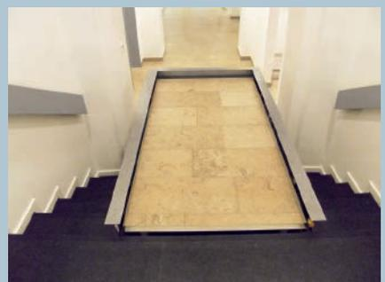
Versenkbarer Hydrolift (hydraulisch)
